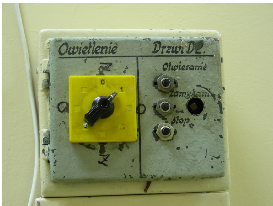
Rysunek 25 stara skrzynka sterująca drzwiami.
