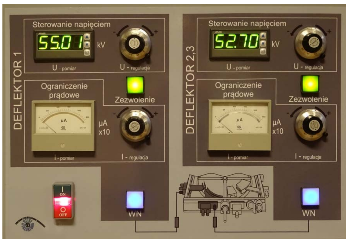
Rysunek 14. Widok nowego układu sterowania zasilaczami deflektorów na pulpicie Cyklotronu AIC-144.
