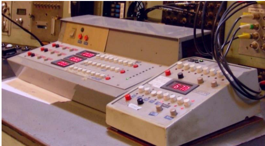
Rysunek 15. Stary pulpit sterowniczy do obsługi napędów Cyklotronu AIC-144.
