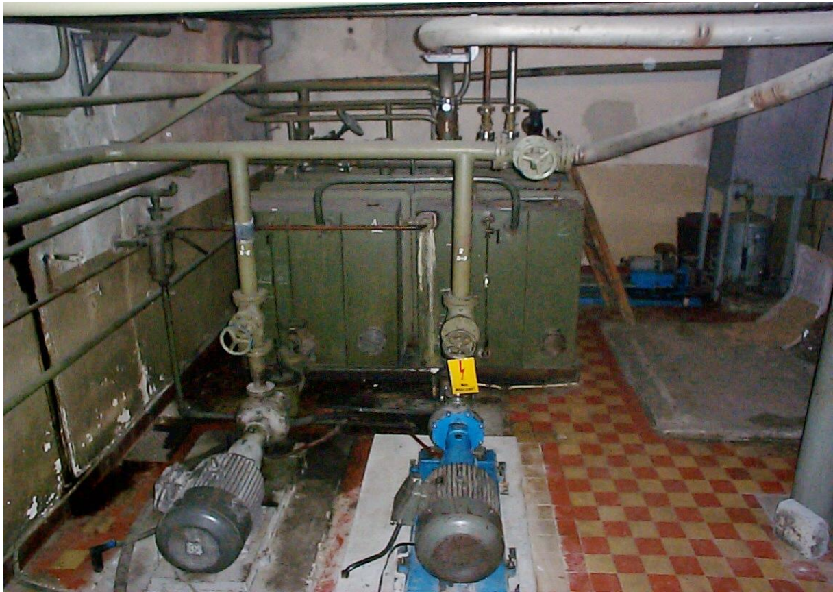
Rys. 18. Widok pompowni przed remontem.
