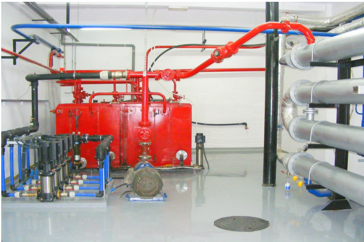
Rys. 19. Widok pompowni po remoncie.
