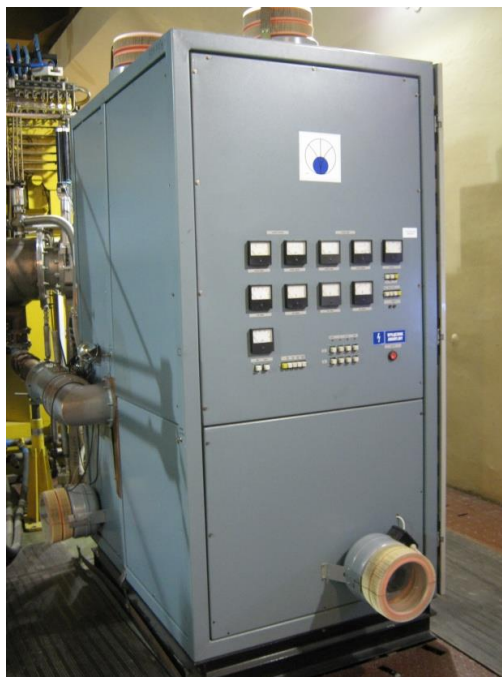
Rys. 3. Wzmacniacz lampowy Cyklotronu AIC-144.
