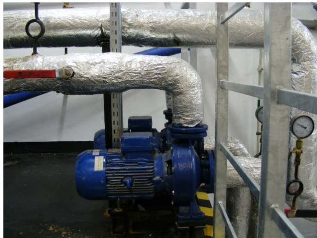
Rys. 14. Pompa o regulowanej wydajności [15].
