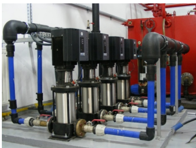
Rys. 8. Pompy wody demineralizowanej.
