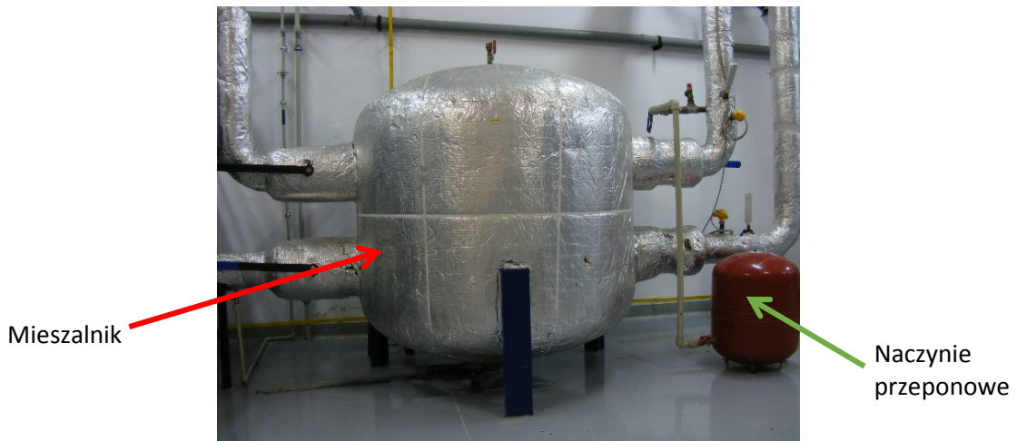
Rys. 13. Mieszalnik z naczyniem przeponowym [12].
